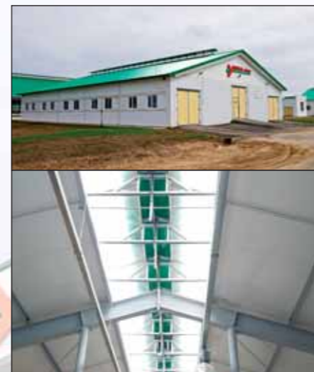
Vetranie v maštali je zabezpečené pomocou stredových svetlíkov (dole), ktoré je možné v prípade vysokej snehovej pokrývky zdvihnúť, čím sa obnoví prúdenie vzduchu v maštali na pôvodnú úroveň. Dole je detail svetlíka, ktorý ukazuje, že toto zariadenie slúži aj ako prirodzený osvetľovací zdroj.
