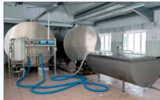
Špičková technológia skladovania (vľavo chladiace cisterny na mlieko s kapacitou 19 t) spolu s rekuperačnou jednotkou (vpravo), ktorá dokáže vymeniť „odpadové“ teplo vznikajúce pri chladení mlieka na ohrev technologickej vody na farme.
