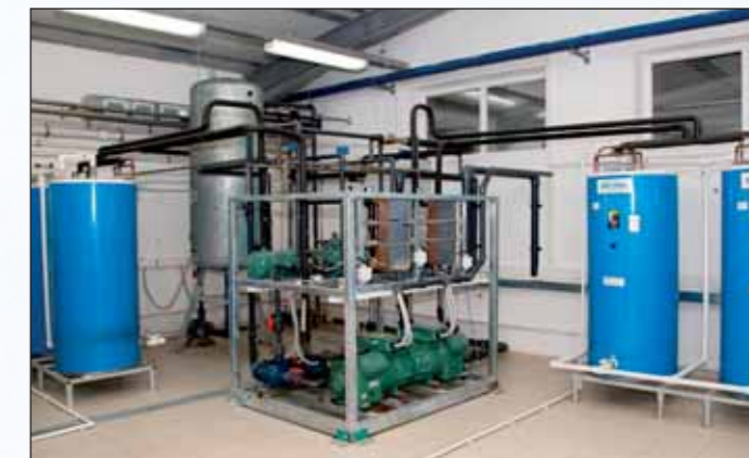
Špičková technológia skladovania (vľavo chladiace cisterny na mlieko s kapacitou 19 t) spolu s rekuperačnou jednotkou (vpravo), ktorá dokáže vymeniť „odpadové“ teplo vznikajúce pri chladení mlieka na ohrev technologickej vody na farme.
